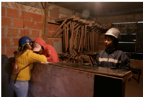
Femmes sur un chantier d'auto-construction de logement populaire par les familles « Mutirao » à Sao Paulo, Photo Magali Fricaudet
